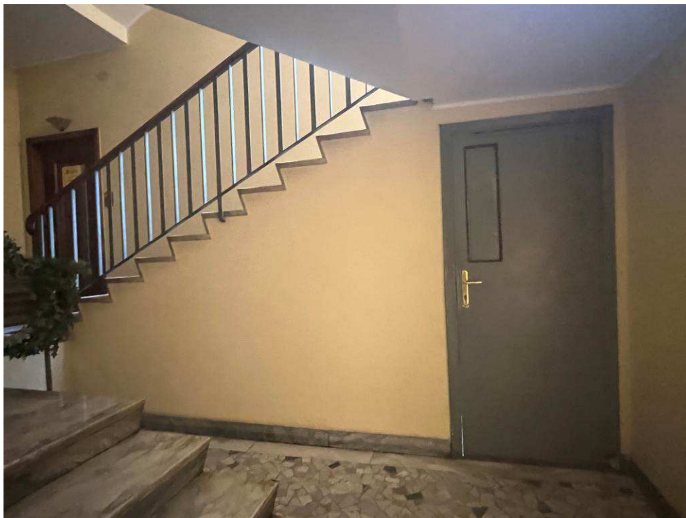
Fotografia n. 36 – Vista della porta di accesso ai locali cantina al piano seminterrato (Corpo A)
