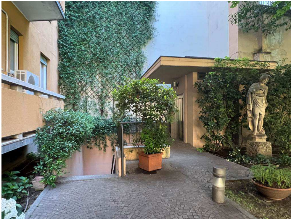
Fotografia n. 43 – Vista del corpo ascensore e della scala esterna di accesso alle autorimesse ai piani sotterranei (Corpo B)
