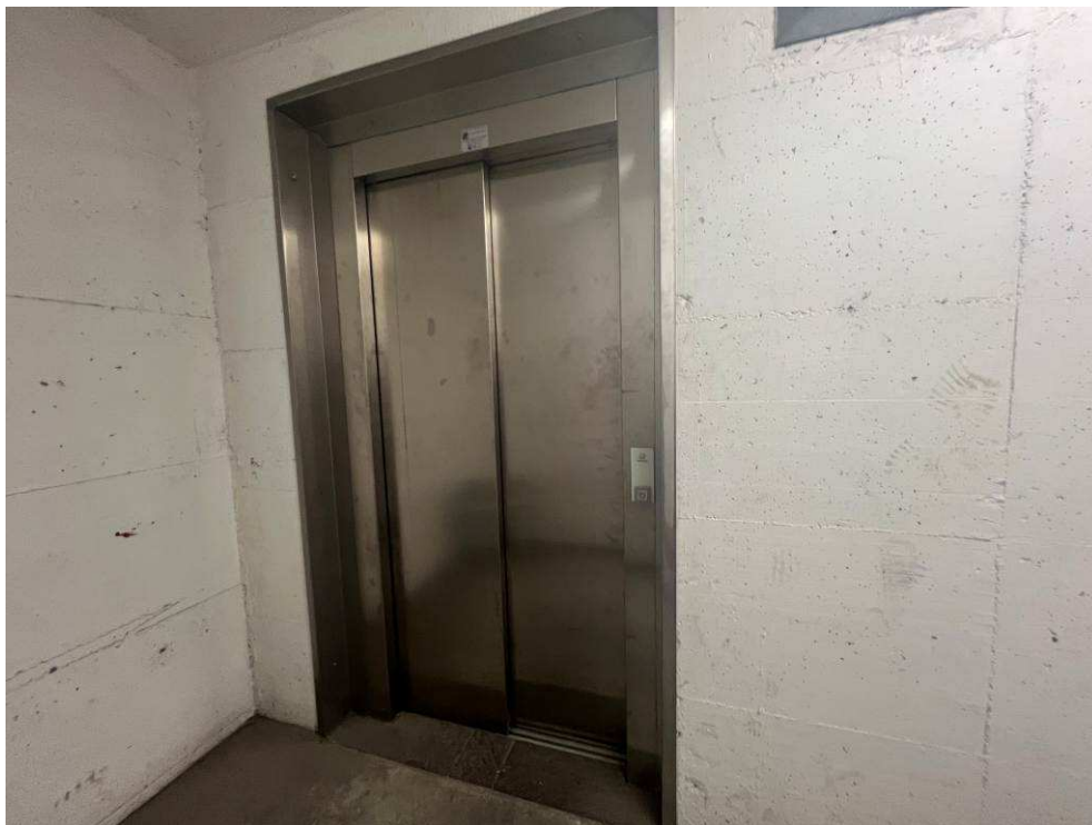
Fotografia n. 45 – Particolare dell'ascensore che conduce ai piani sotterranei
