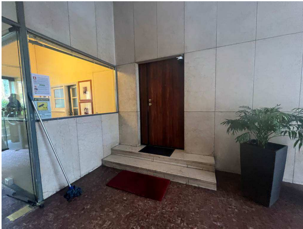
Fotografia n. 12 – Vista dall'esterno della porta di ingresso all'appartamento oggetto della procedura al piano rialzato (Corpo A)
