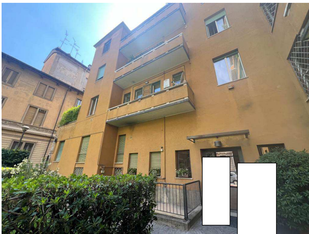
Fotografia n. 9 – Vista del prospetto secondario della palazzina
